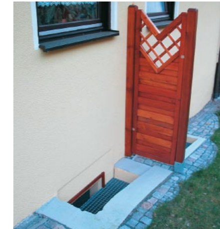
Beispiel lufttechnische Trennung
