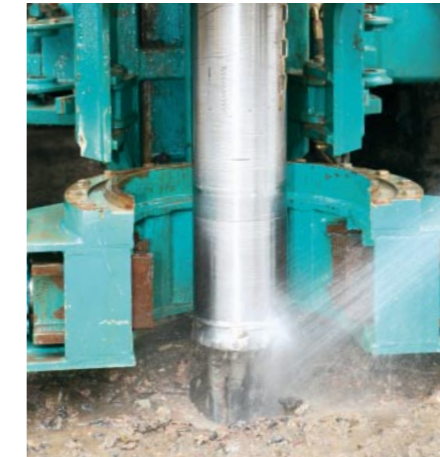
Bohrung für Erdwärmesonde
