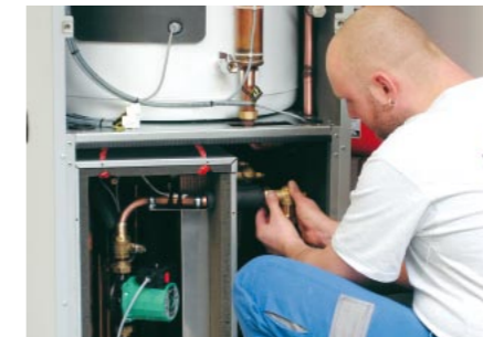
Kältebox anschliessen.
