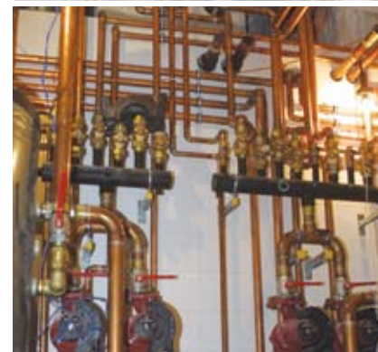
Csővek találkozási pontja a mennyezeten... a hidraulikus rendszer egy része
