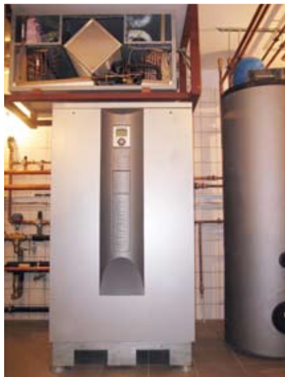
Alphasol hőszivattyú és a hidraulikus modul, ami biztosítja a rendkívül kedvező fogyasztást
