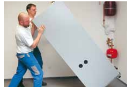
Die Wärmzentrale ankippen und richtig platzieren.
