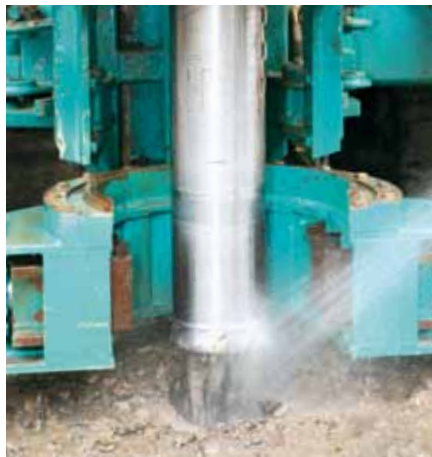
Bohrung für Erdwärmesonde
