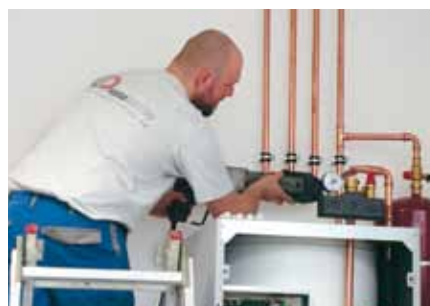
Wärmzentrale endmontieren und verschliessen.
