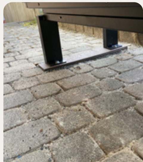
Beispiel: Einbindung in eine bestehende Pflasterung
