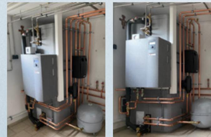
Montagebeispiel mit Anschluss-Set und Hydraulikmodul
