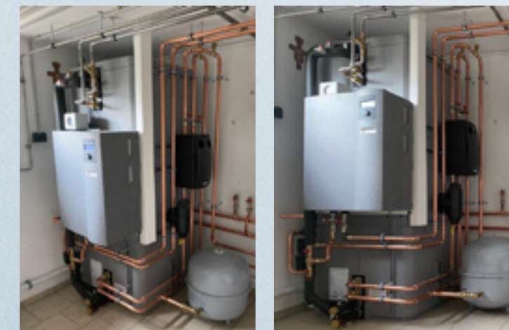
Montagebeispiel mit Anschluss-Set und Hydraulikmodul
