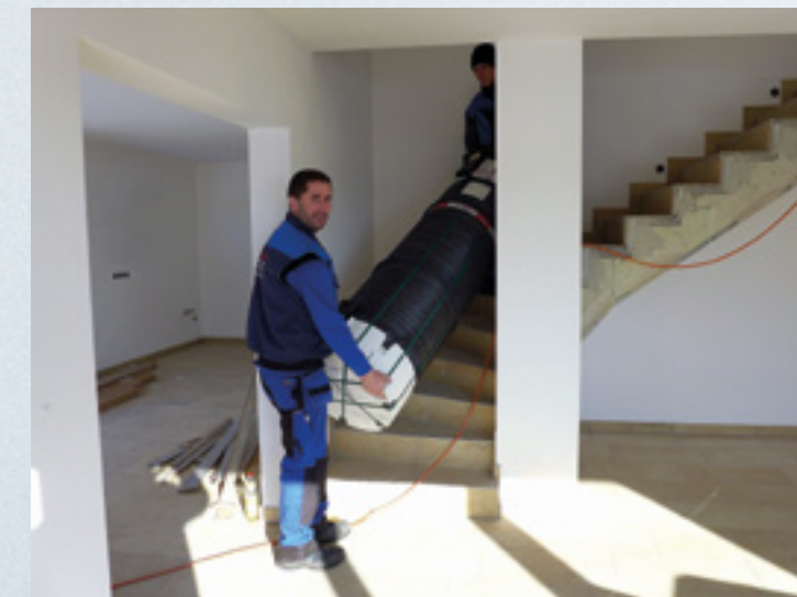
Der Kunststoff-Wärmetank wiegt nur ein Drittel eines herkömmlichen Stahlspeichers und vereinfacht so den Transport über Treppenstufen hinweg.
