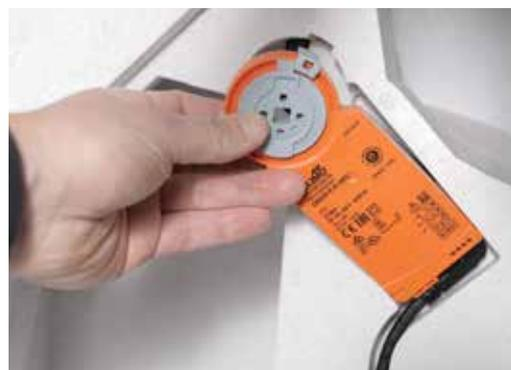
Stellantrieb für Bypass entfernen.
