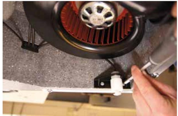
Stellantrieb für Bypass entfernen.
