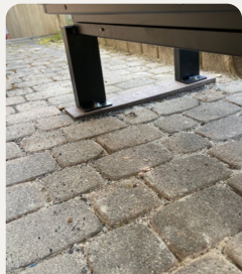
Beispiel: Einbindung in eine bestehende Pflasterung
